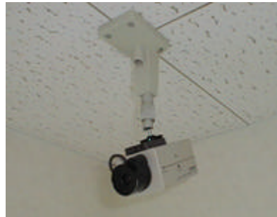
屋内外 12箇所設置の ネットワークカメラ設置
